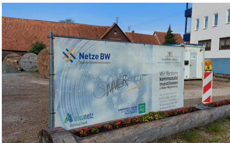
Baustellenschild in der Ortsmitte
