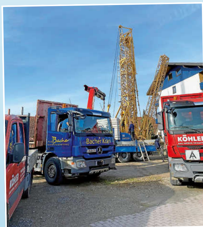
Der Kran wird gestellt 20.03.2024
